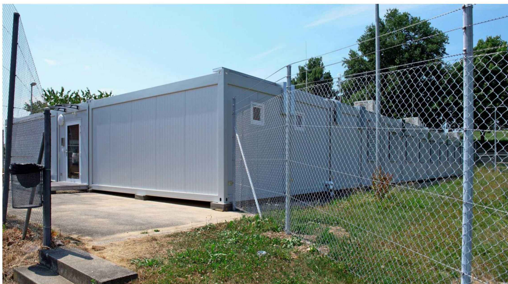
Auch die Justizvollzugsanstalt Wauwilermoos (Bild) arbeitet mit Containern für den den offenen Vollzug.
