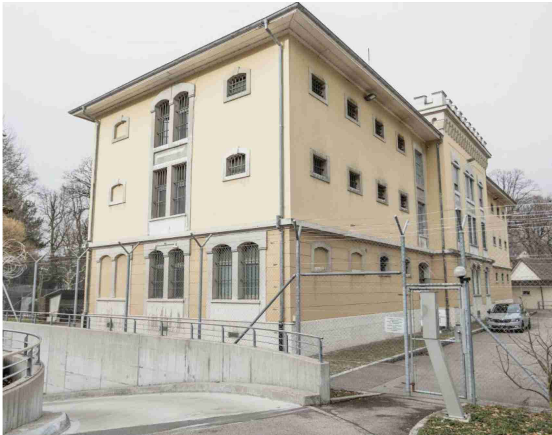
Das Regionalgefängnis in Biel hat bald ausgedient. Für 280 Millionen Franken will der Kanton Bern einen Ersatz in Witzwil bauen. Etwa 2032 soll das Gebäude bereit sein. FRANK NORDMANN/A
