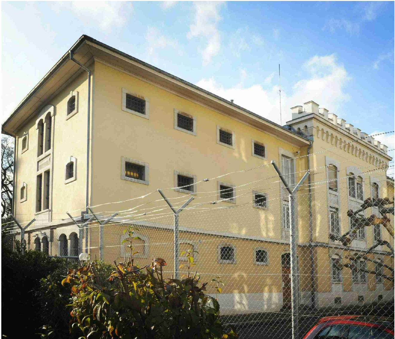
Ein Überbleibsel aus alten Zeiten: Das über 100-jährige Bieler Regionalgefängnis ist baufällig und muss ersetzt werden. Foto: Adrian Streun
