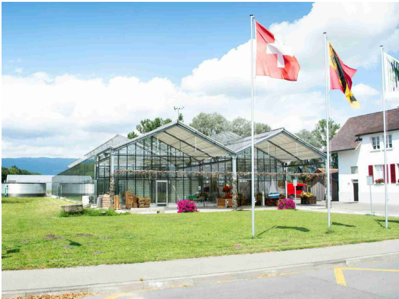
Das Gelände der Strafvollzugsanstalt Witzwil ist gut erschlossen und liegt in einer bestehenden Bauzone. YANN STAFFELBACH
